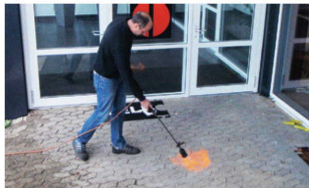
Fjern fugt fra underlaget ved let opvarmning med en gasbrænder, og lad det køle af igen.
