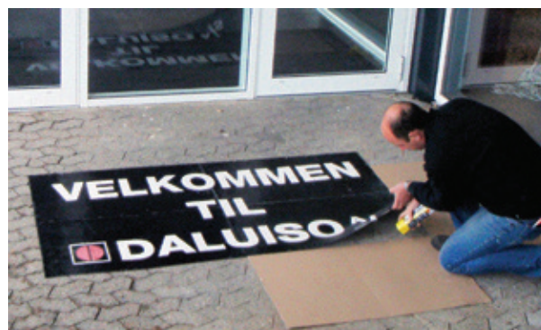
På gammel asfalt, beton eller fliser, er primer nødvendig før termoplasten kan monteres. Afmærk derfor symbolets placering nøjagtigt. Kridt eller anden ikke permanent markering anbefales.
