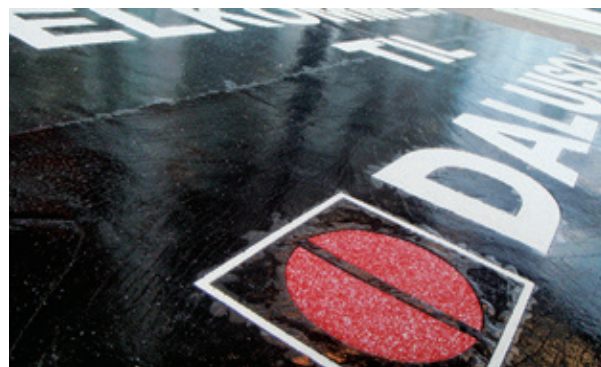
Saml symbolet med den perlebelagte side opad, og sørg for at alle dele støder helt op til hinanden inden opvarmningen.
