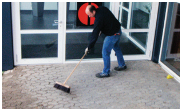
Fej underlaget grundigt som det første.
