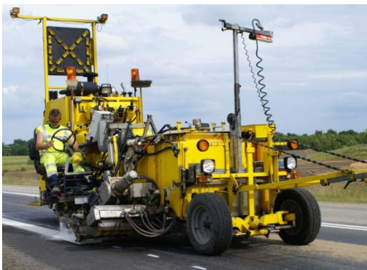
Figur 5.2 Eksempel på afstribning af kantlinje.
