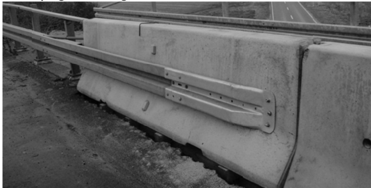
Figur 7.43 Eksempel på overgang mellem trafikværn og autoværn.!
