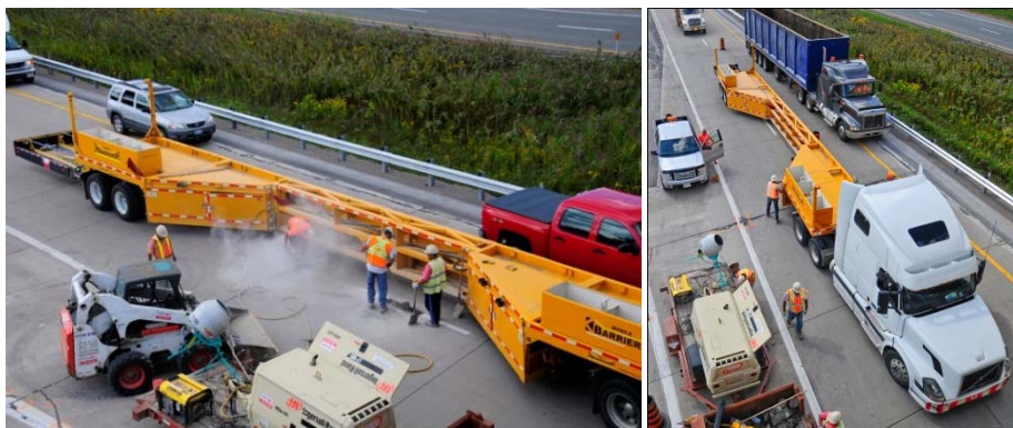
Figur 7.55 Eksempel på beskyttelsesmodul (her mobile-work-zone-barrier).
