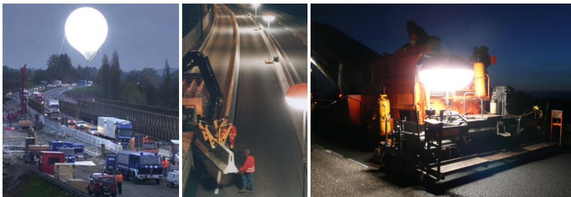
Figur 2.3 Eksempler på ballonbelysning af arbejdsområdet
