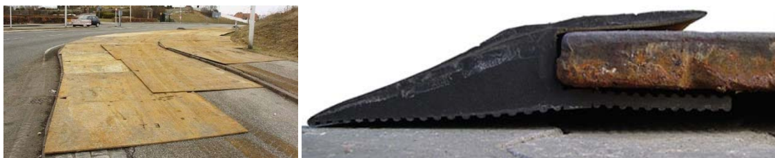
Figur 7.70 Eksempler på køreplader og gummirampe til køreplader.
