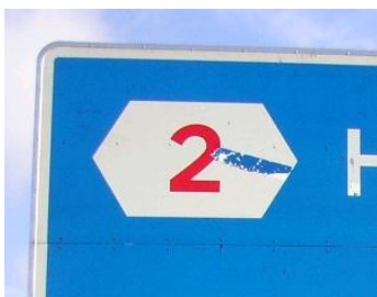
Figur 1.2. Tavler med ødelagt folie.
