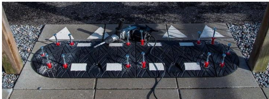
Skruer og plugs skal sættes i ovenfra
